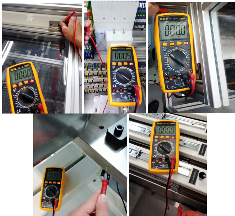
Medição Aterramento da Linha
