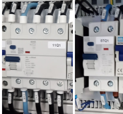
Disjuntor Diferencial Residual (DR)
