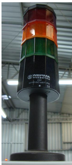
Figura 58 – Sinalização Segurança (Coluna Luminosa)
