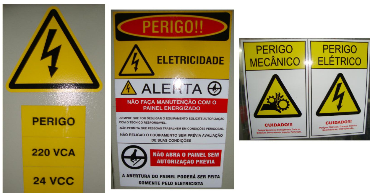
Figura 56 – Adesivos Identificação Perigos Elétricos e Mecânico
