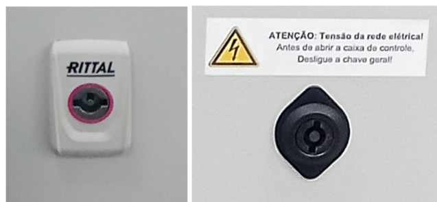
Fechaduras para Abertura dos Painéis Elétricos
